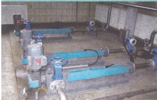
Die Nemo M.Champ ist die nahezu wartungsfreie Exzentrerschneckenpumpe aus nur neun Teilen. Foto: Netzsch
